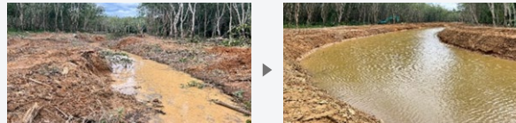
하천 바닥 준설 및 용량 확대를 통해 홍수 대응능력 강화, 하부 댐 연계로 연간 약 7만 톤의 수자원 추가 확보
